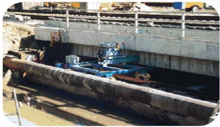
Spezialvorrichtung für Arbeiten unter Brücken mit sehr hohem Grundwasserstand
