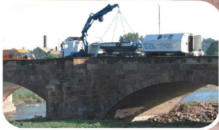
Baustelleneinrüstung bei Brückenbauarbeiten
