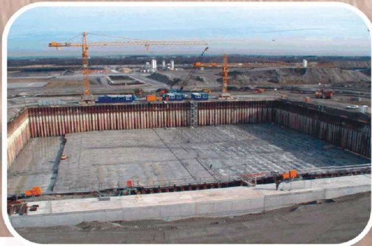
Baugrube nach Betonage im gelenzten Zustand mit Vertiefung der Sohle für den S-Bahn - Tunnel. Betonieren einer ca. 20 m langen Schräge die danach horizontal ausläuft
