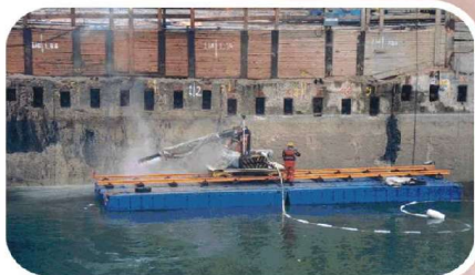
Hochdruckwasserstahlarbeiten an Schlitzwänden während des Lenzens einer Baugrube
