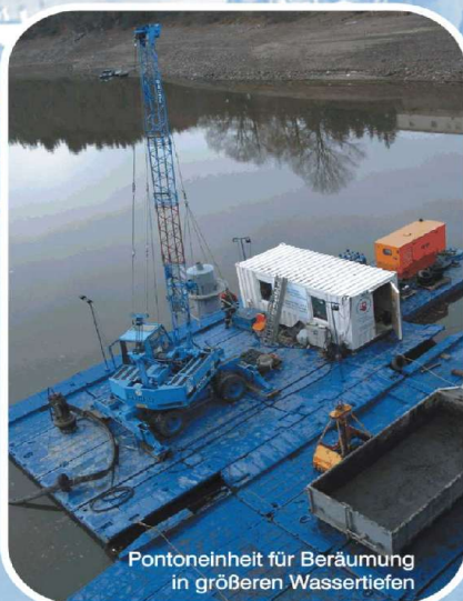
Beräumungsarbeiten an Talsperren
