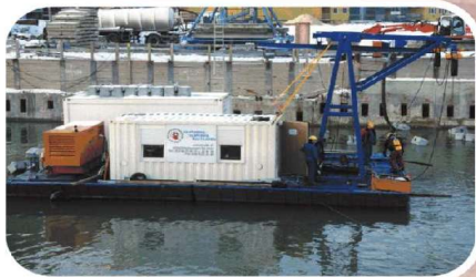
Pontoneinheit mit Tauchcontainer, A-Mast und elektrischen Kettenzügen für Arbeiten in unterschiedlichen Wassertiefen
